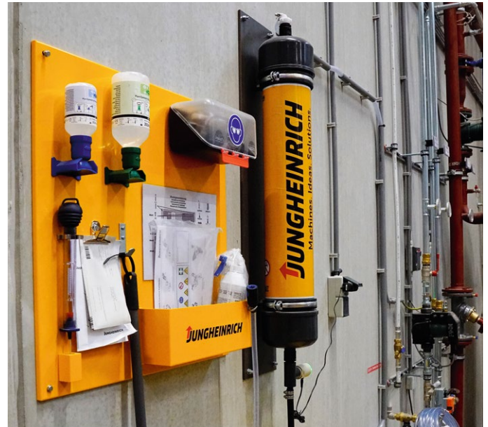
Via demi-patronen maakt Crocs zelf het demi-water voor het bijvullen van de accu's.
