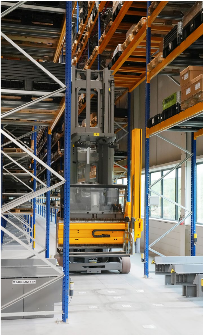
8 automatische smallegangstrucks (VNA) van het type EKX 516a verwerken in totaal 15.000 pallets in de twee hoogbouwmagazijnen.
