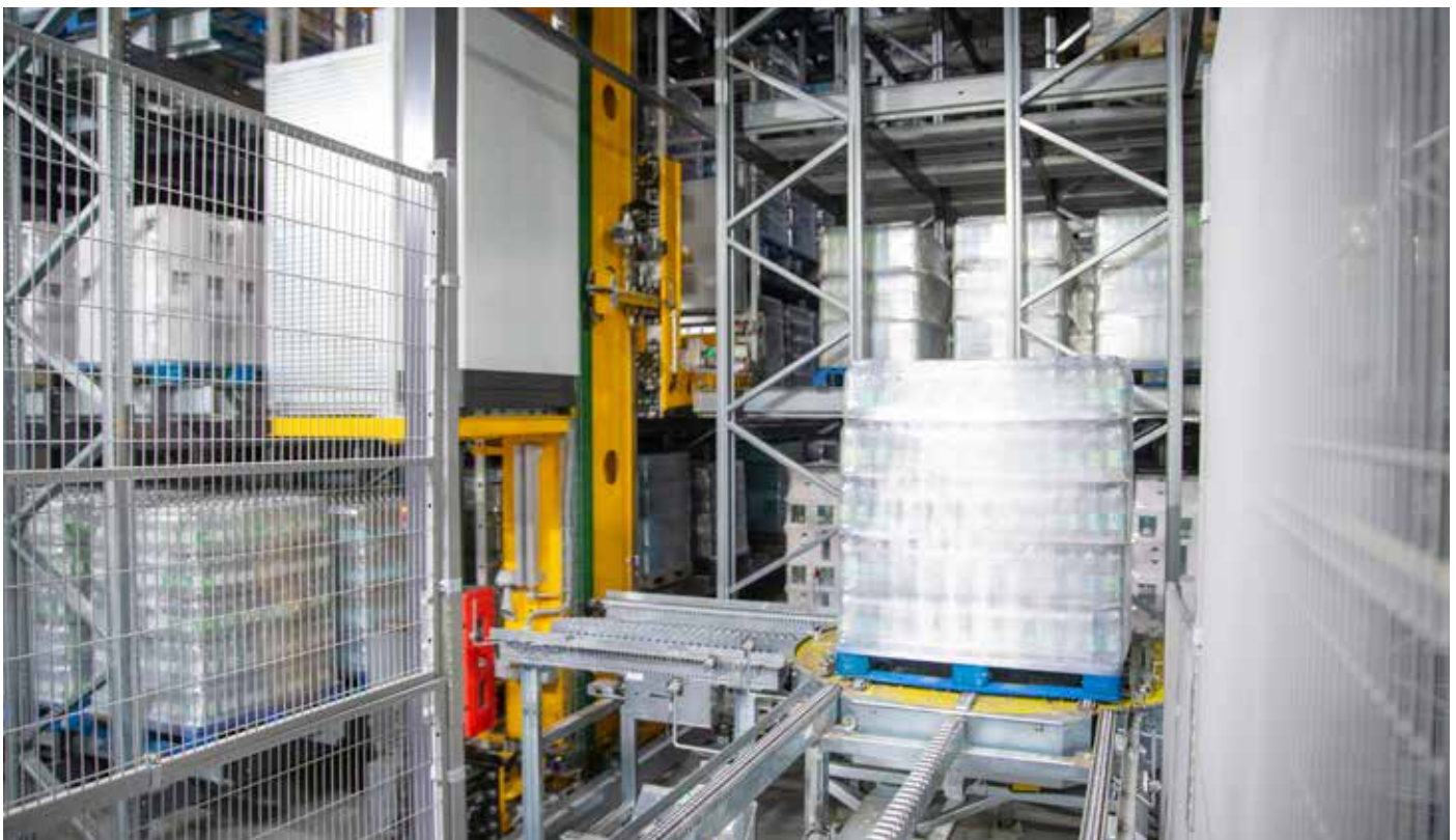
Via een conveyor wordt de pallet afgeleverd bij het juiste gangpad en op de UPC-shuttle gereden, die op de magazijnkraan klaarstaat.
