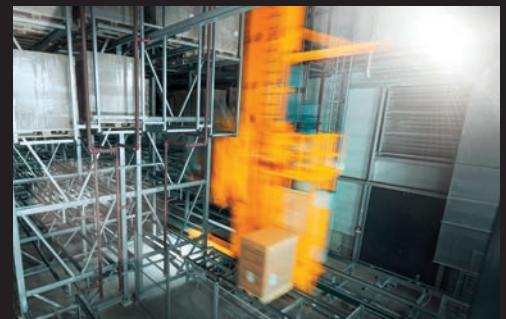
Più spazio: i trasloelevatori assicurano uno stoccaggio compatto, a doppia profondità.
