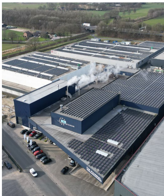
Het nieuwe magazijn biedt plaats aan ruim 7.000 pallets, goed voor een verdubbeling van de opslagcapaciteit.
