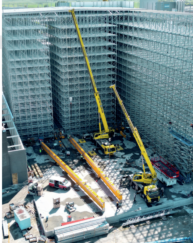
Het nieuwe hoogbouwmagazijn in aanbouw: een oppervlakte van 2.500 m 2 biedt straks ruimte aan 22.000 palletlocaties.
