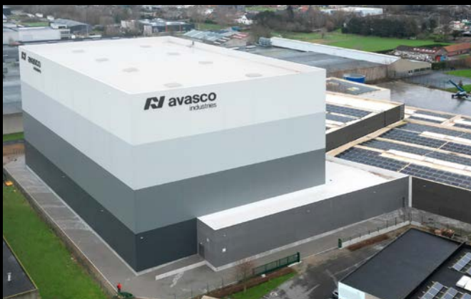
Das neue Hochregallager von Avasco
