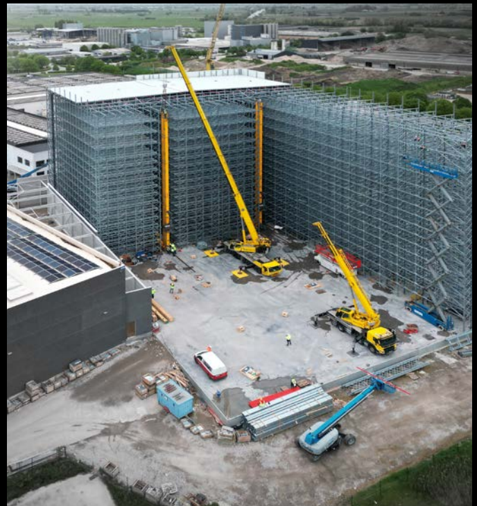
Das neue Hochregallager im Bau: Eine Fläche von 2.500 m 2 bietet künftig 22.000 Palettenstellplätze.
