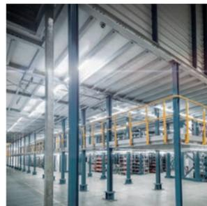
La construction autoportante de la plateforme en acier permet de créer un espace supplémentaire sur plusieurs niveaux.
