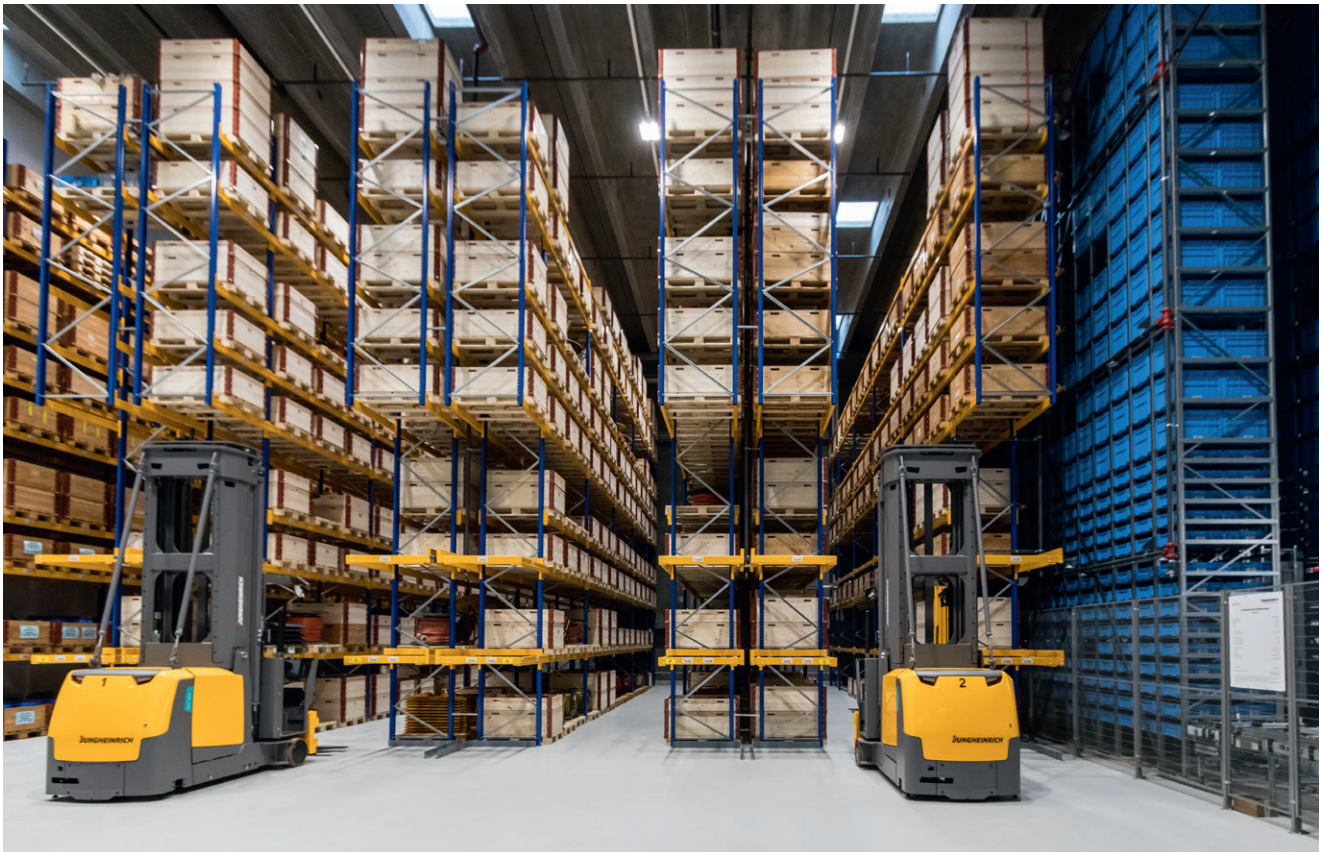
Das halbautomatische Palettenlager verfügt über zwei Schmalgangstapler.
