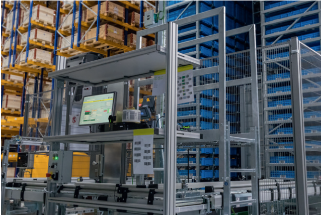
Arbeitsplatz im Kleinteilelager mit Bedienoberfläche LASOFT.
