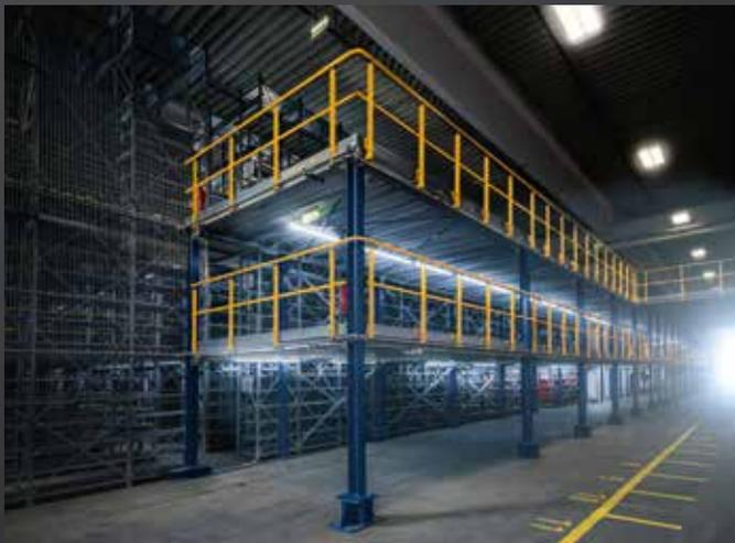
**Stahlbaubühne:** Selbsttragende, begehbare und optional befahrbare Stahlkonstruktion, die durch zusätzliche Ebenen neue Arbeitsflächen schafft.
