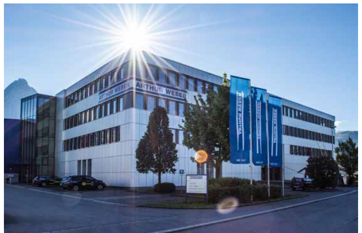
Firmengebäude Arthur Weber AG
