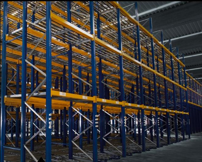
Beim Einschubregal erfolgt die Einlagerung typischerweise in Längsrichtung durch Gabel- oder Schubmaststapler.
