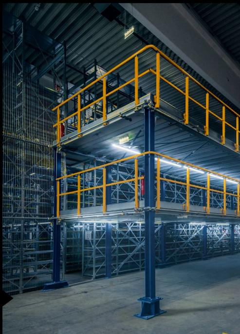
Umfassendes Sicherheitszubehör: Geländer, Rammenschutz, Stützenschutz und mehr sorgen bei der Stahlbaubühne für maximalen Schutz von Mensch und Maschine.
